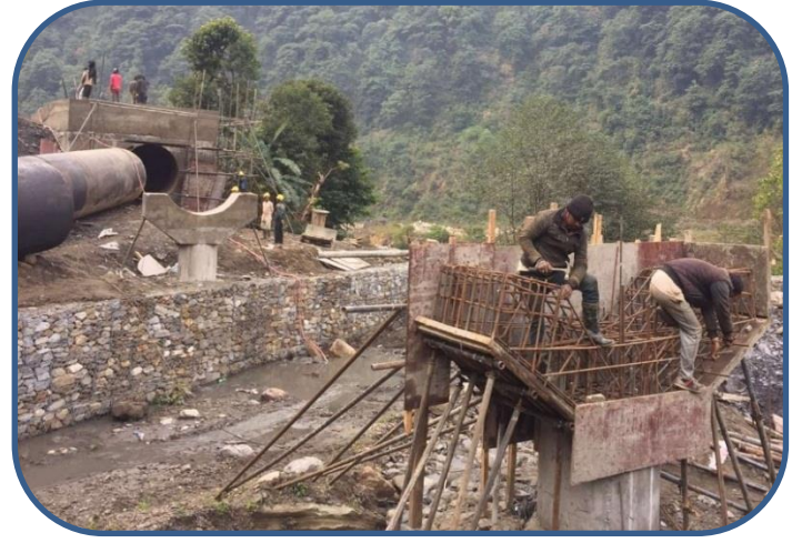
पेनस्टक पाइपको लागि खोलामाथी पुल निर्माण गरिँदै ।
