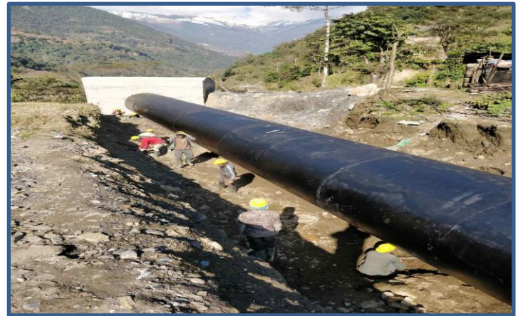
आयोजनाको Penstock पाइप लाइन जडान गर्दैको एक झलक
