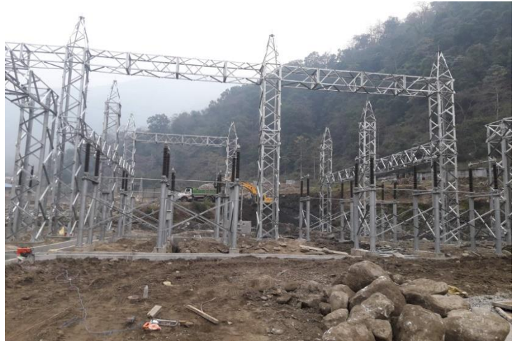
किर्तिपुर सब स्टेसनको निर्माणाधिन कार्य प्रगति ।
