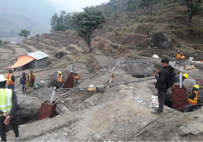
Transmission line Foundation निर्माण को कार्य गरिँदै ।
