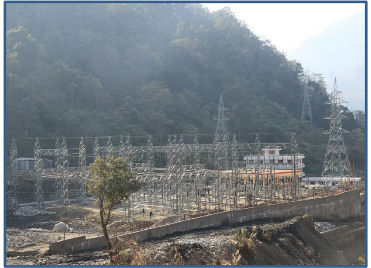
किर्तिपुर सब स्टेसनको निर्माणाधिन कार्य प्रगति ।
