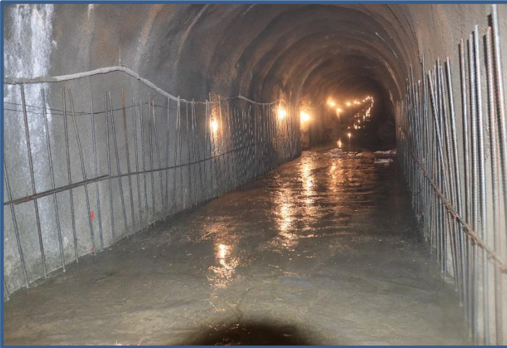
आयोजनाको Tunnel को फलक ।
