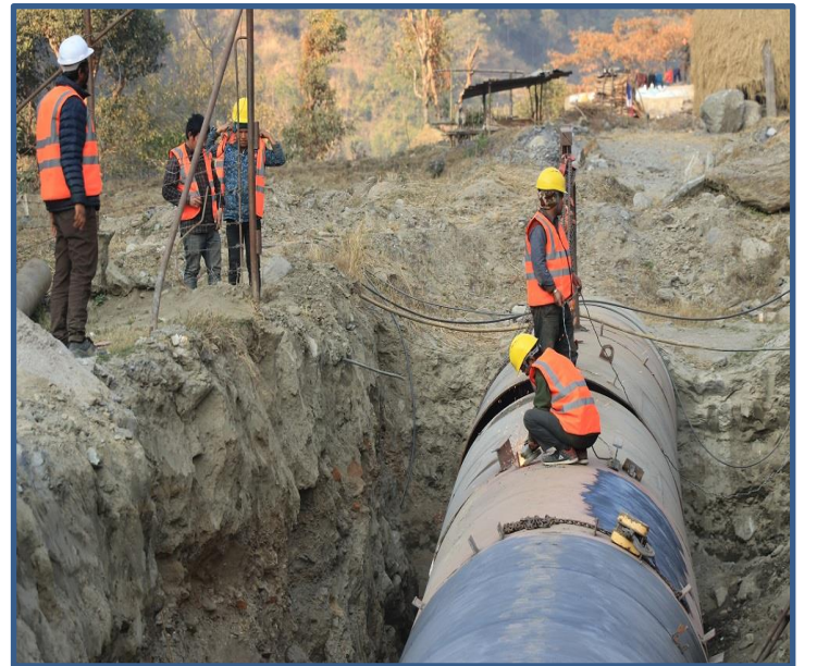
आयोजनाको Penstock pipe जडान गर्ने गरिदै ।
