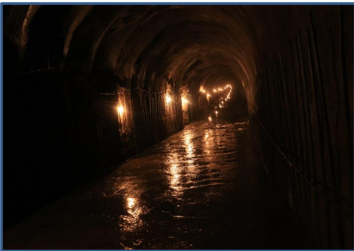
आयोजनाको सुरुङ निर्माण स्थलको कार्य भलक ।
