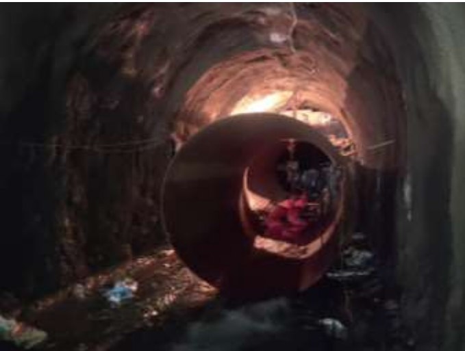
आयोजनाको सुरुङ्ग निर्माण स्थलमा पाइप Plug-in को कार्य भ्रलक ।
