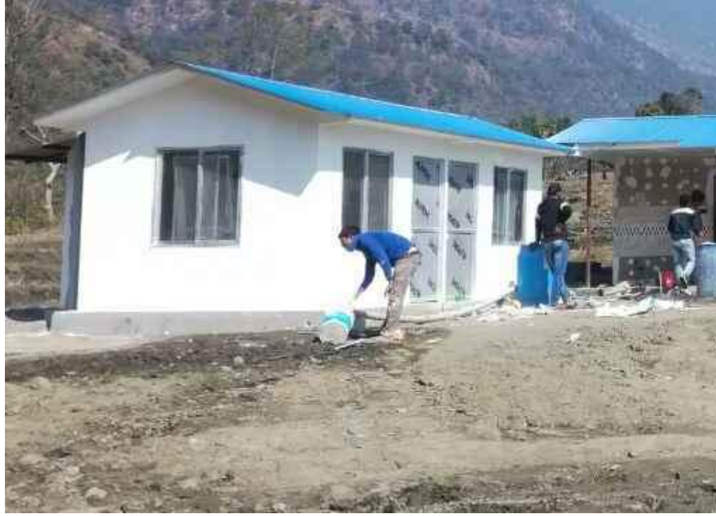
निर्माणाधीन क्याम्प हाउस
