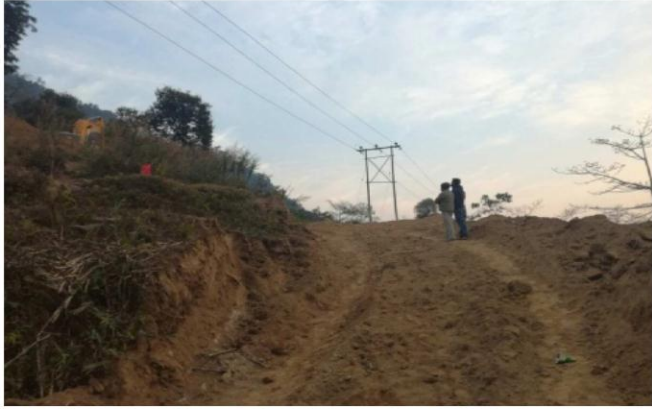
मुख्य सडक देखि सर्ज ट्याङ्क पुग्ने बाटो
