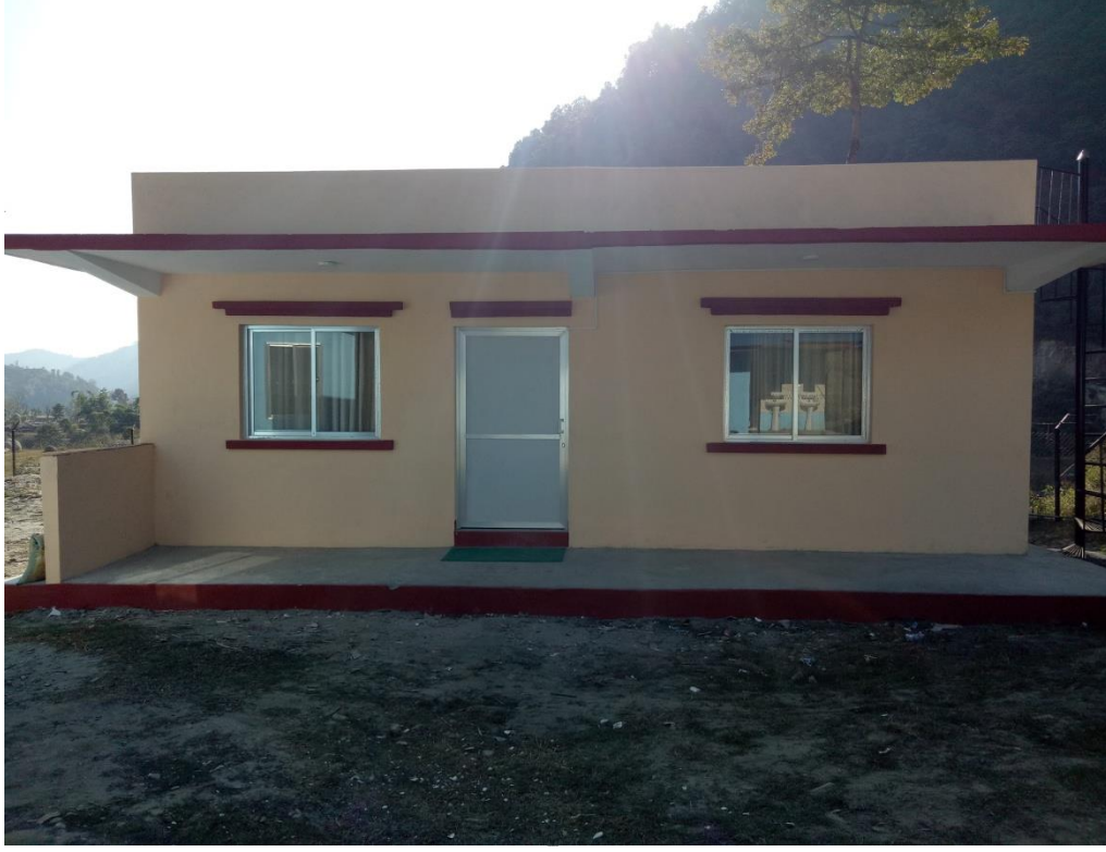
RCC क्याम्प हाउस
