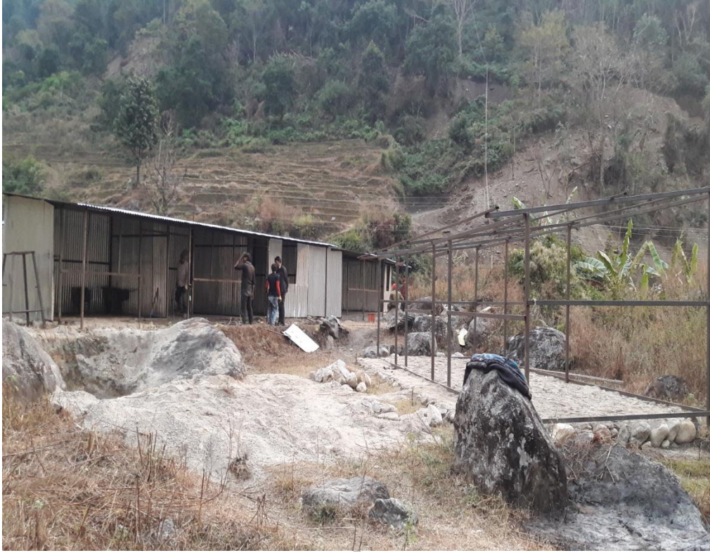
माउन्टेन इन्फ्रा कम्पनी प्रा. लि.को निर्माणाधीन क्याम्प हाउस
