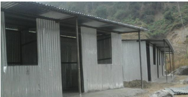
माउन्टेन इन्फ्रा कम्पनी प्राइभेट लिमिटेडको निर्माणाधीन कर्मचारी आवास गृह
