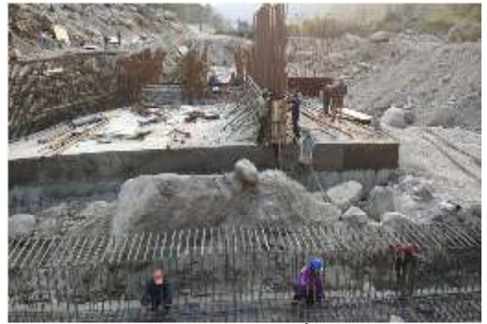
अन्डरस्लुइसको निर्माण कार्य गरिदै।
