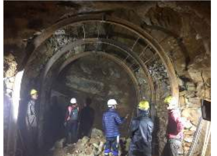
आयोजनाको प्राविधिक बाट सुरुङ्गको निरिक्षण
