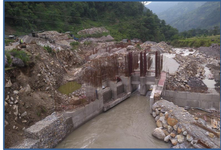
अन्डरस्लुइस तथा इन्टेक क्षेत्रमा हालसम्म भएको निर्माण कार्य ।
