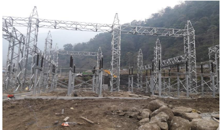
किर्तिपुर सबस्टेसनको निर्माणधिन कार्य प्रगति ।
