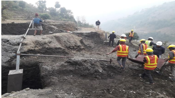
Transmission line Foundation निर्माण को कार्य गरिदै ।
