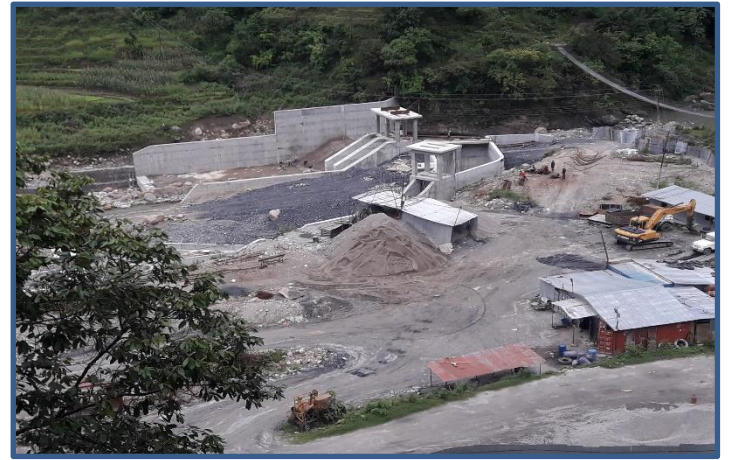
आयोजनाको Headworks क्षेत्रको झलक ।
