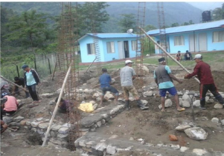
निर्माणाधीन क्याम्प हाउस
