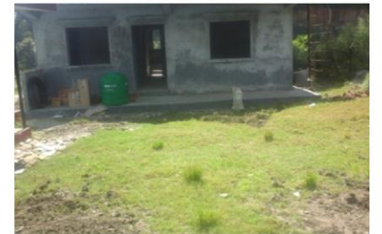
निर्माणाधीन RCC क्याम्प हाउस
