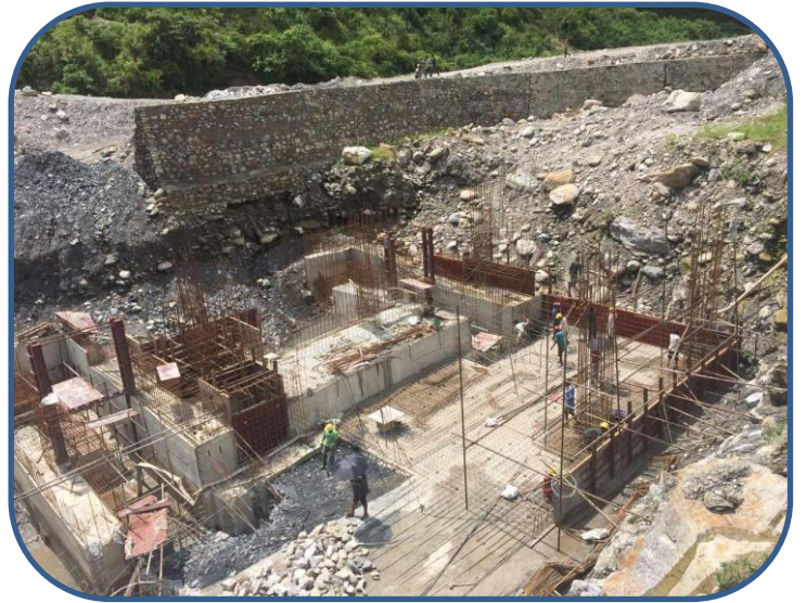
आयोजनाको विद्युतगृहमा भईरहेको निर्माण कार्य ।
